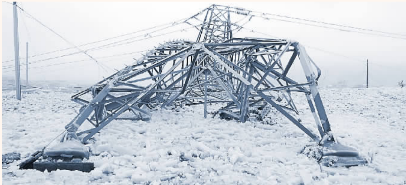
2008年年初的雪灾中,南方地区多地出现大雪结冰压塌通讯设施的事件,导致多个地区省份出现停电情况
