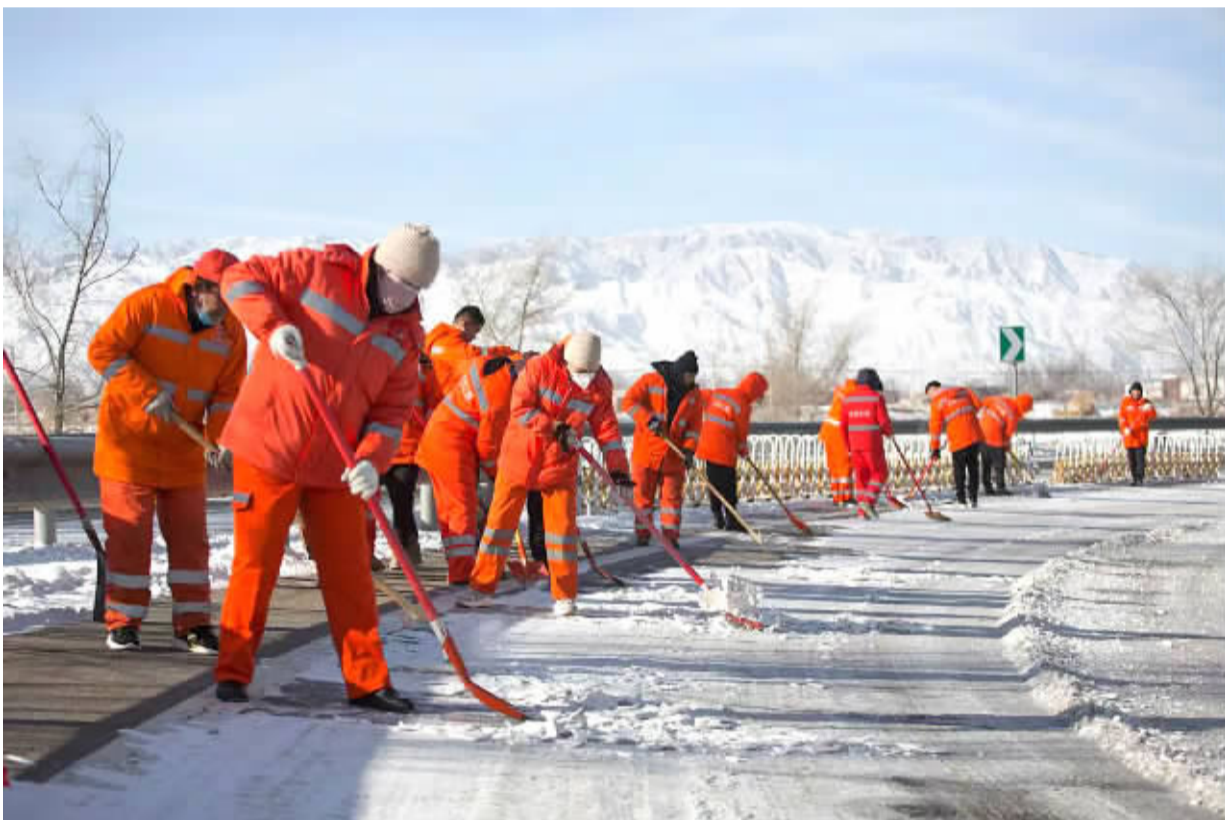
12月16日,甘肃省武威公路事业发展中心民勤公路段职工在武威高速匝道口进行除雪防滑作业(新华社发 姜爱平/摄)
