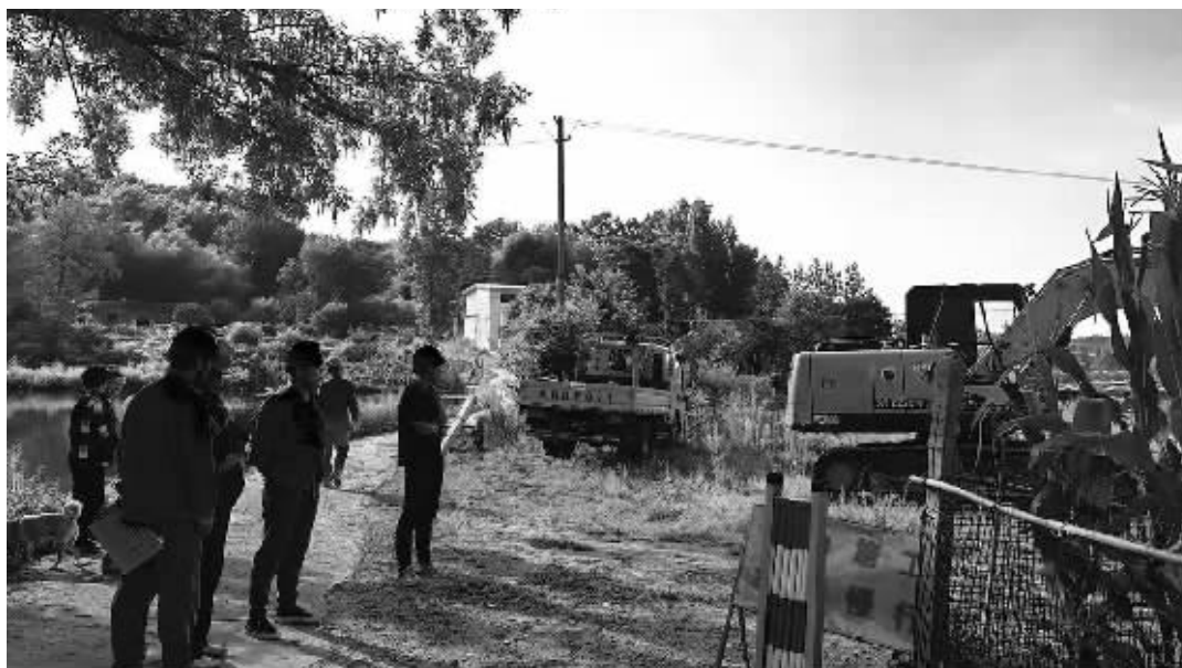
在驻村社工协调下,国网金寨县供电公司施工人员为金寨县梅山镇徐冲村安装变压器,缓解了当地村民夏天用电难问题(陈雪梅/摄)
