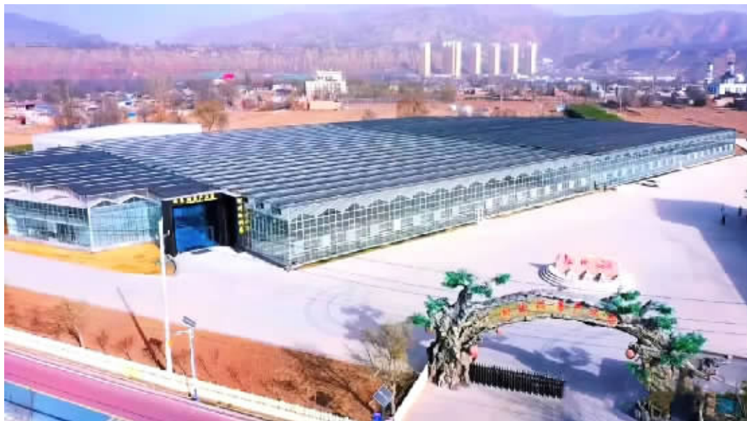
甘肃省临夏州临夏市—山东省济南市市中区东西协作共建树莓产业园
