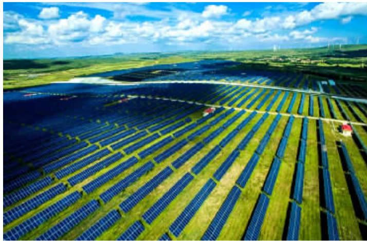
位于张家口张北县与尚义县交界的国家风光储输示范工程,一排排光伏板和白色风车在阳光的照射下熠熠生辉。北京冬奥会上100%采取的绿色电力,主要从张家口吹向各大赛区,为冬奥场馆的平稳运行提供绿色保障
