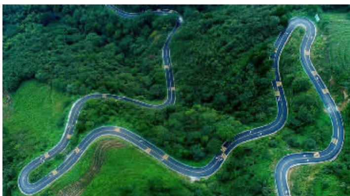
庐江县汤池镇盘山公路
