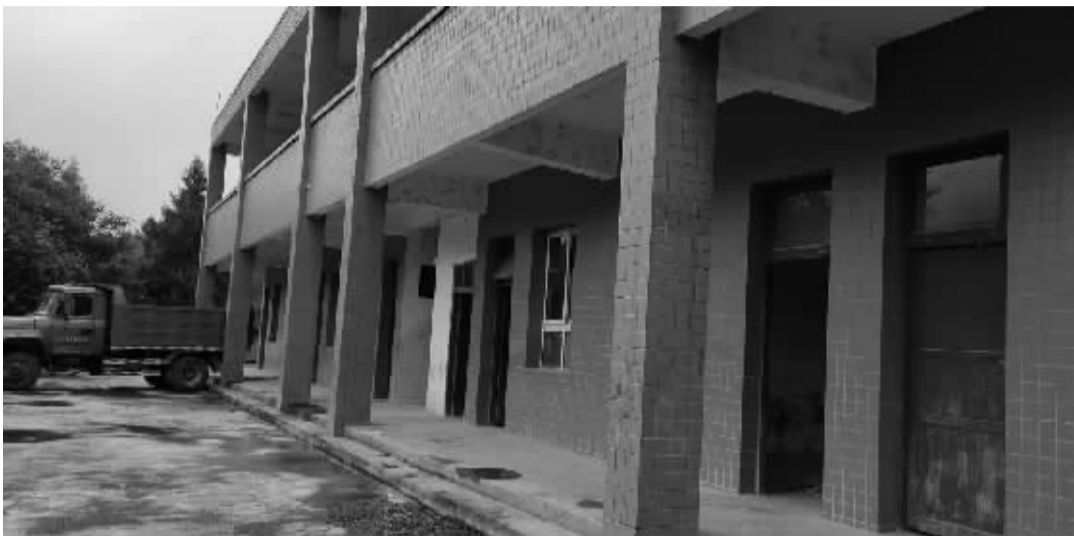
7 月 18 日,红光古天乐小学已经开始施工整修,院内停放着施工车辆
