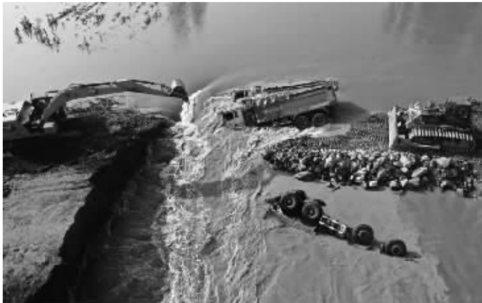
7月25日,满载石料的重型卡车被推入卫河鹤壁市浚县新镇彭村段的决口处(无人机照片)(新华社记者 张浩然/摄)
