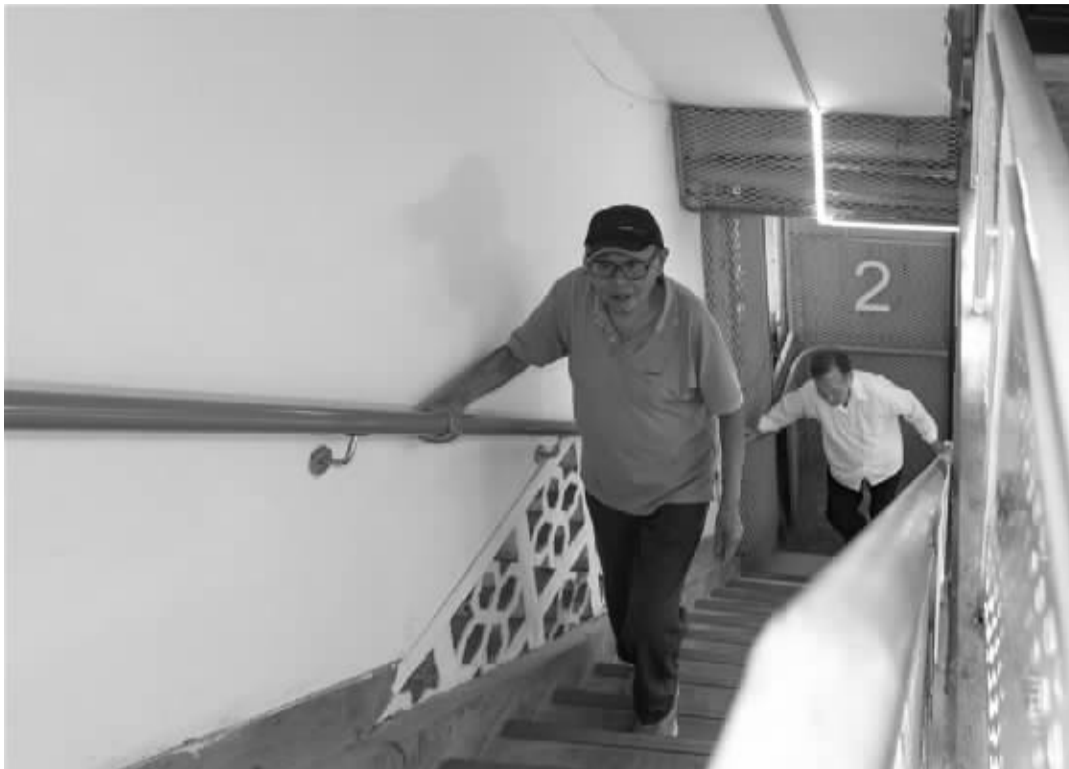
9月23日,在电机片区一栋居民楼内,楼道内新增的扶手、灯光和楼层标志为老人上下楼提供了便利(新华社记者 王翔/摄)
