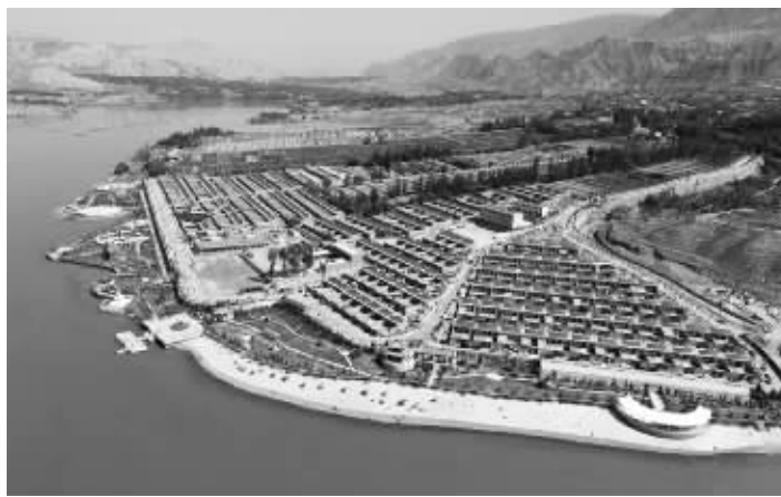
中国华能为对口支援的青海尖扎县德吉村易地扶贫搬迁安置点安装屋顶光伏
