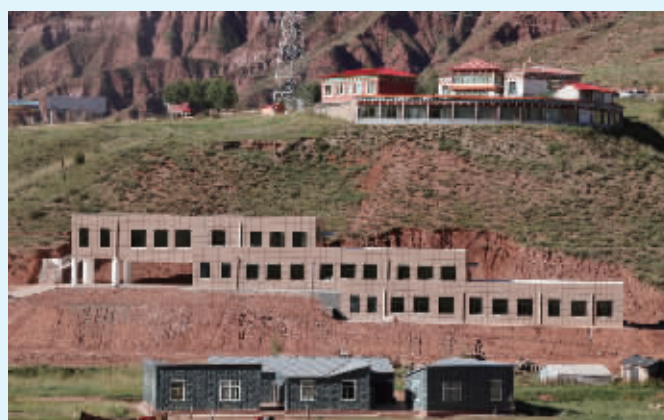
落成的新教学楼
